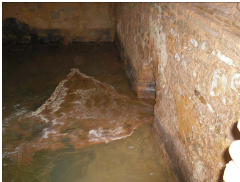
Figura 2.7: Local da nascente da água de Itaparica.
