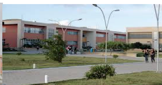
Figura 3 – Prédios de aulas e laboratórios
