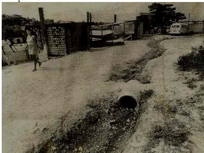
Figura 13 - Falta de saneamento básico em Dom Avelar, no Miolo de Salvador, chama a atenção no Jornal A Tarde
