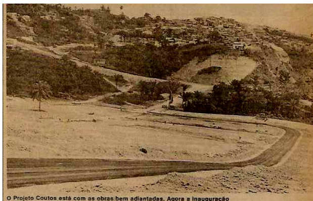
Figura 6 - Terraplanagem de Coutos para implantação de residências no governo Mário Kertész
