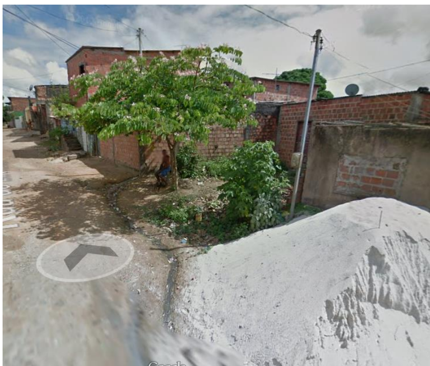
Figura 21 - Esgoto na Rua do Lavrador, em Valéria
