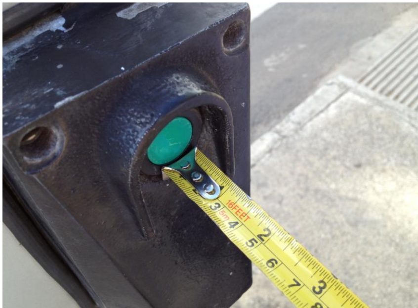
Figura 47- Botão de acionamento do semáforo.
