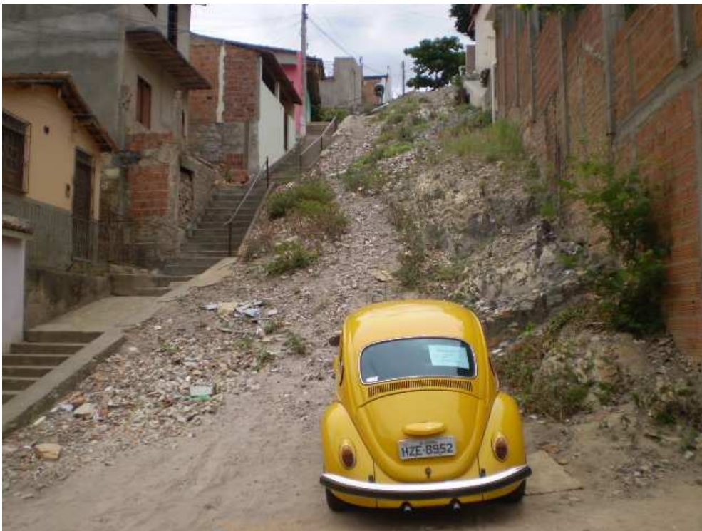
Figura 21 - Casas edificadas em áreas declivosas com pouca infraestrutura, bairro Leader
