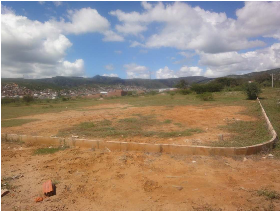
Figura 28 - Área aterrada para a construção de loteamento no bairro Nazaré (setor 29)
