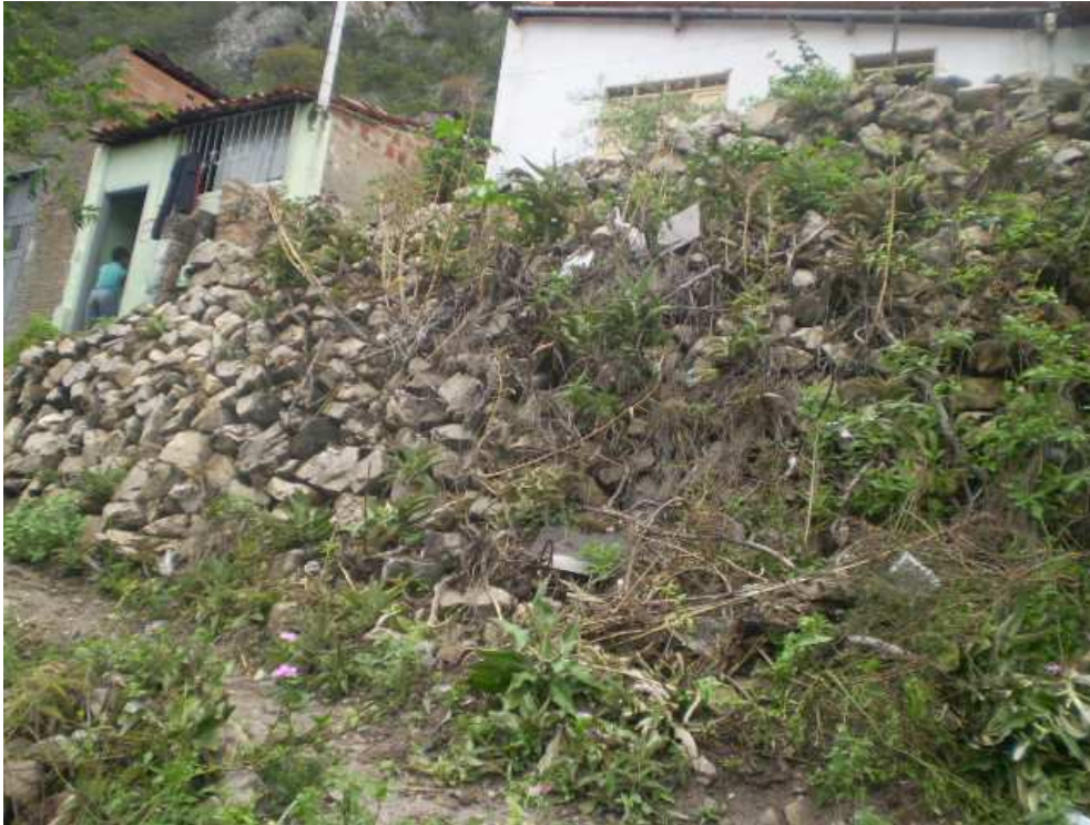
Figura 20 - Blocos rolados utilizados para contenção de terreno em encosta íngreme no bairro Grotinha
