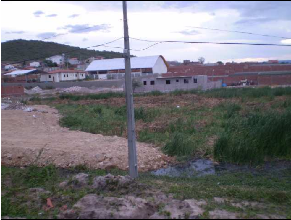
Figura 17 – Aterro em área úmida, bairro Jacobina II
