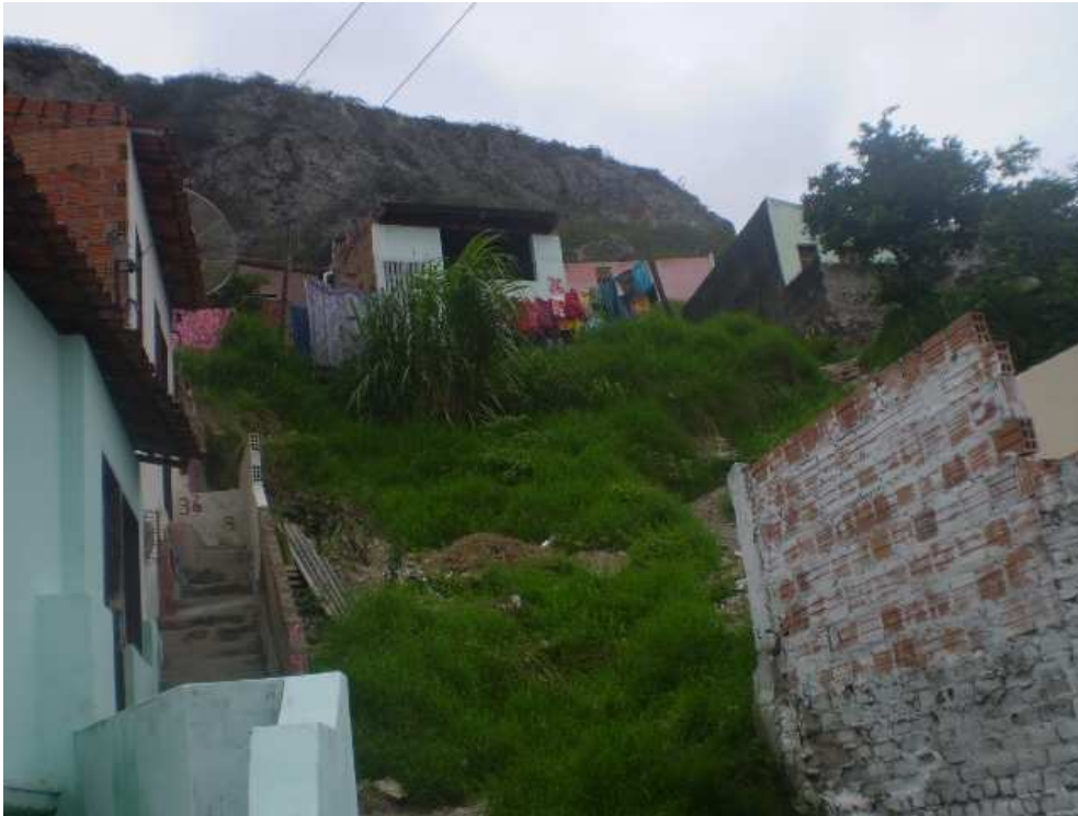
Figura 13 – Exemplo de construções em área de elevada declividade, no bairro Grotinha
