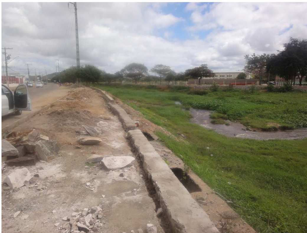
Figura 61 - Avenida João Fraga Brandão: obras sendo realizadas nas margens do rio Itapicuru-Mirim
