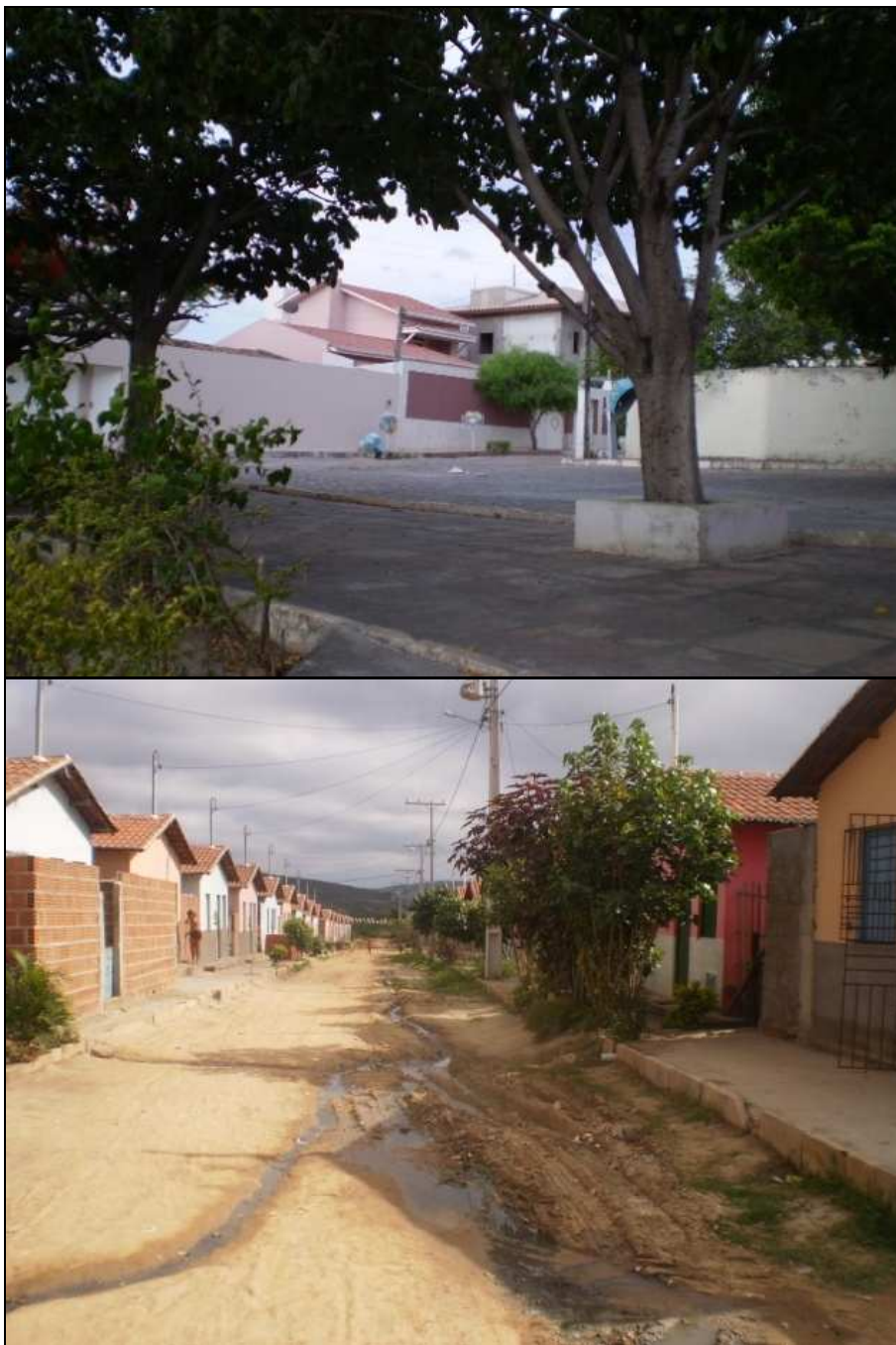
Figura 53 - Bairro Inocoop (acima): casas de padrão elevado e ruas com boa infraestrutura; loteamento Novo Amanhecer (abaixo): casas de padrão simples e ruas com infraestrutura ruim, pavimentação precária e sem canalização para esgotamento de águas servidas
