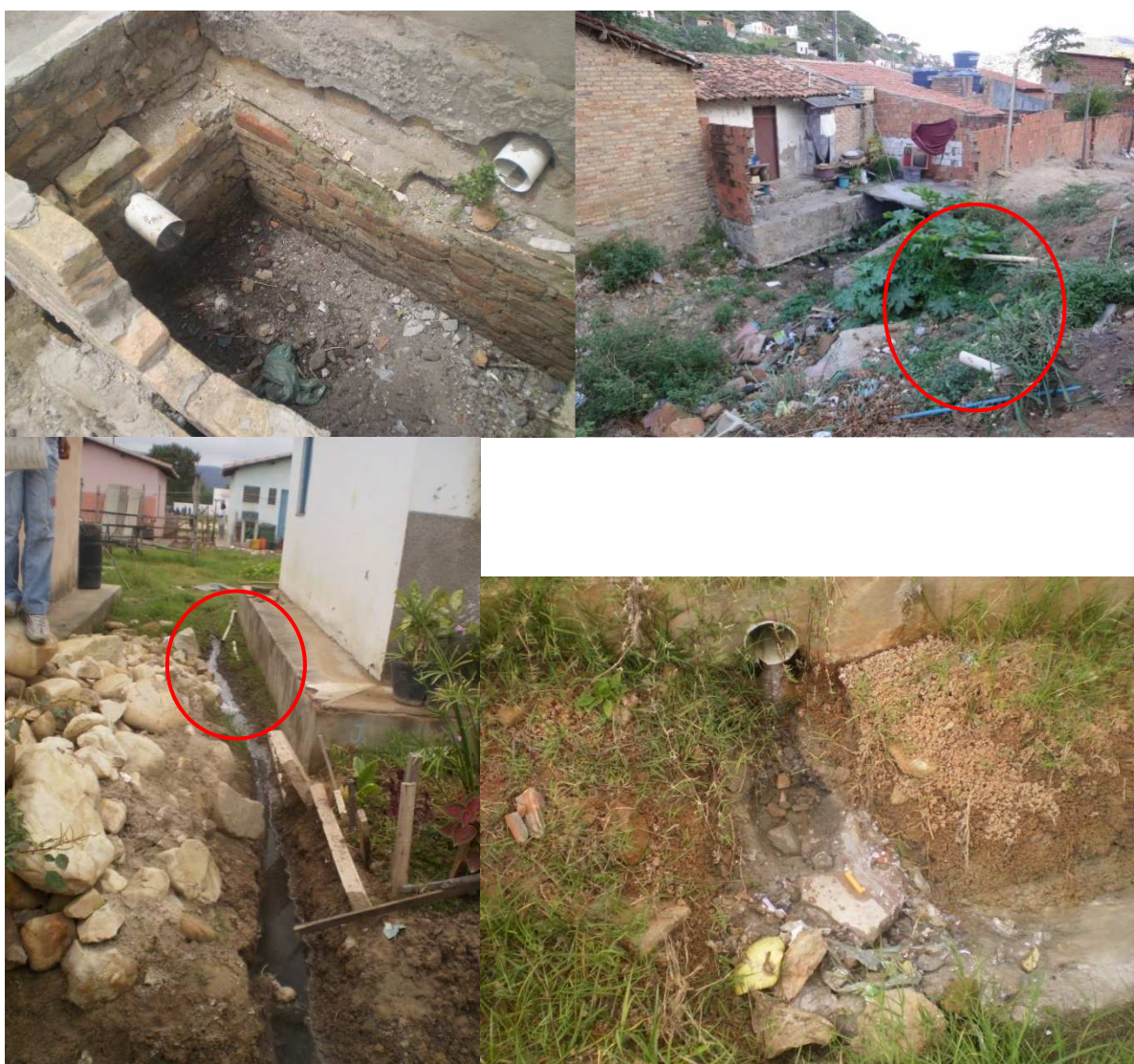
Figura 49 – Lançamento de águas servidas em bueiro, em canais de drenagem e nos terrenos e ruas, bairro Grotinha (acima) e Novo Amanhecer (abaixo) que corresponde a um loteamento construído pelo poder público
