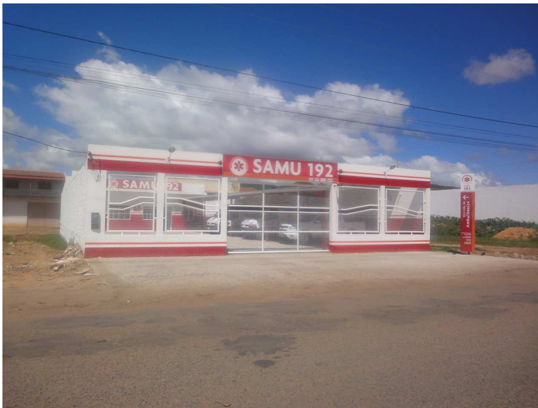
Figura 62 - Órgão administrado pelo município que funciona na Avenida Paulo Souto, em local que corresponde a uma área úmida aterrada e, ao mesmo tempo, encontra-se dentro da faixa de 30 m de Área de Proteção Permanente definida pelo Código Florestal
