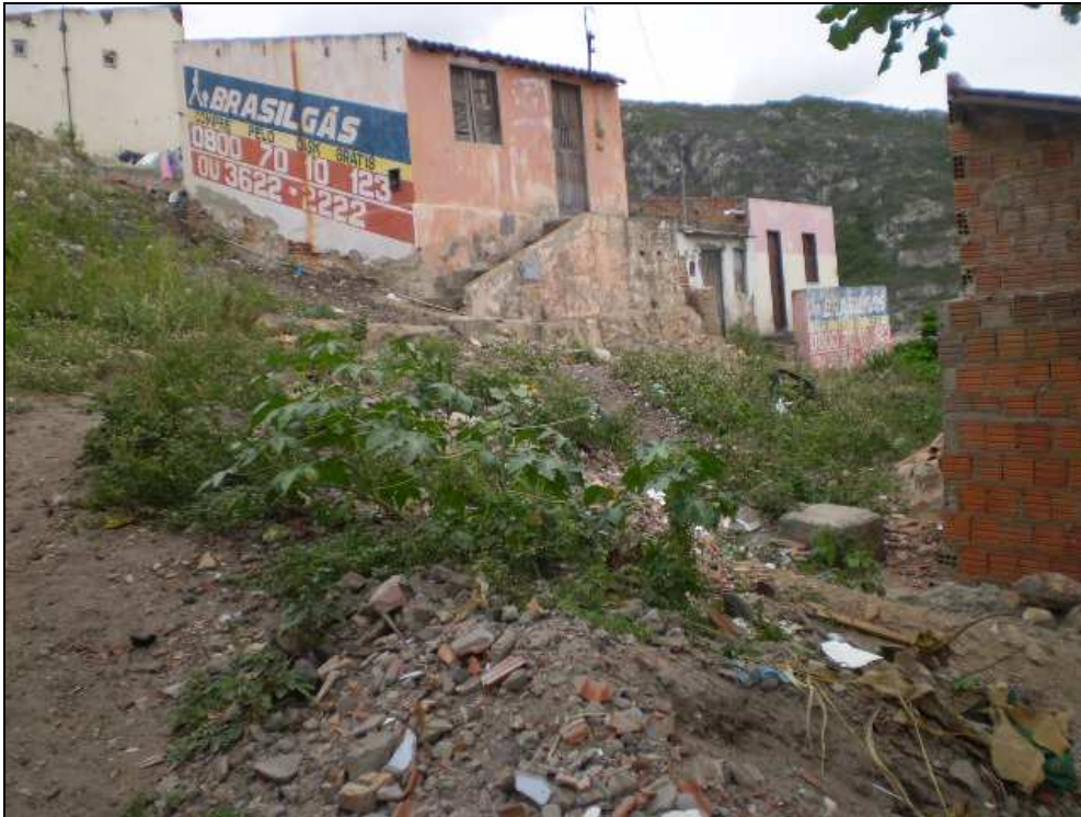
Figura 22 - Bairro Caixa D'Água: moradias de difícil acesso
