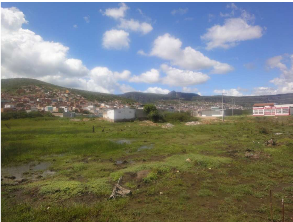
Figura 16 – Avanço das construções, sobre aterros, em direção a uma área úmida, bairro Nazaré
