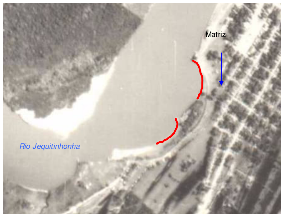
FIGURA 22: CIDADE DE BELMONTE (1964) – PROCESSO EROSIVO DESENCADEADO PELO RIO JEQUITINHONHA SOBRE A CIDADE
