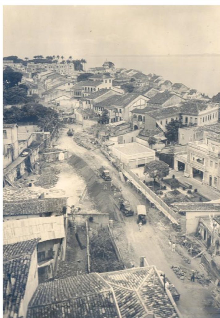
Figura 15: Rua Carlos Gomes, demolições.
