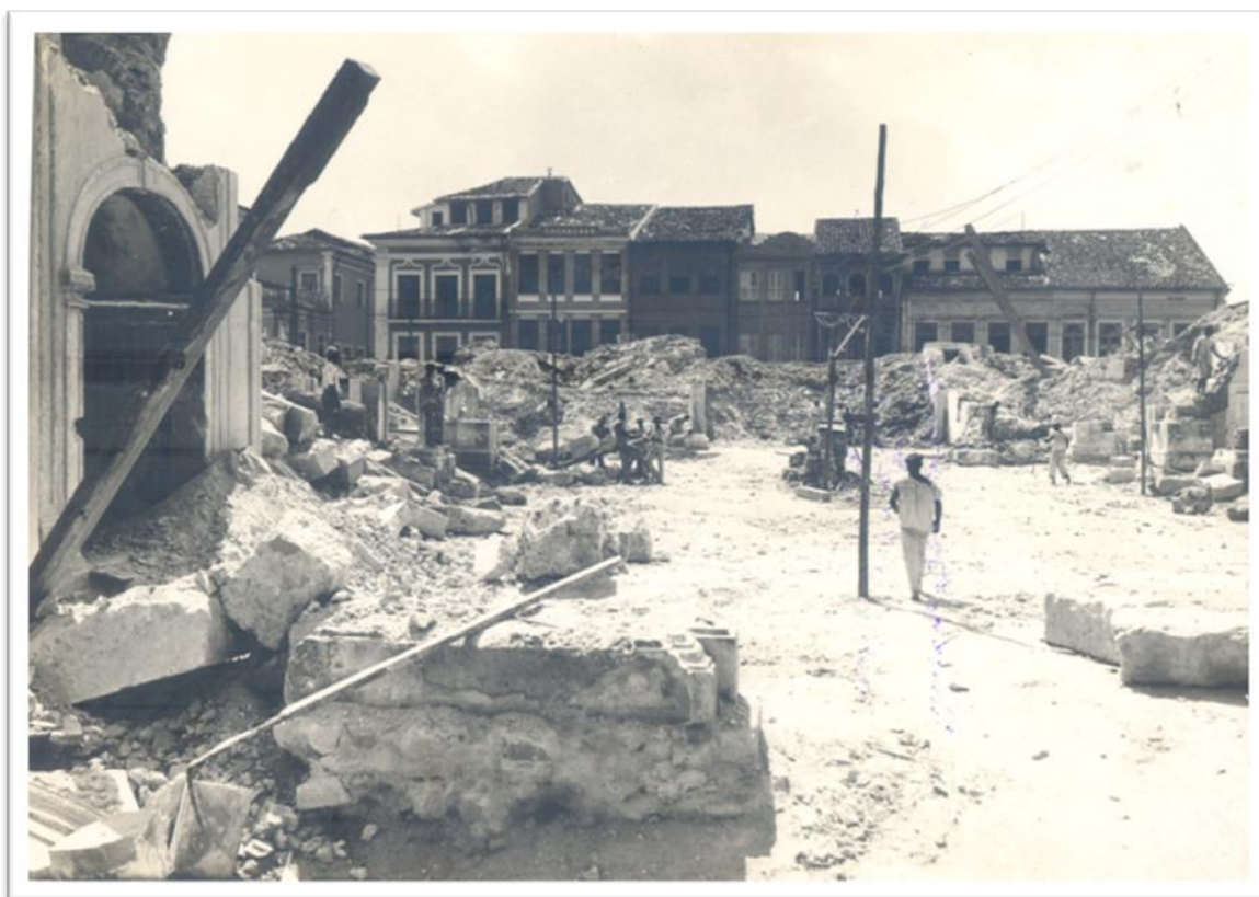
Figura 8: Demolição da Igreja da Sé, 1933.
