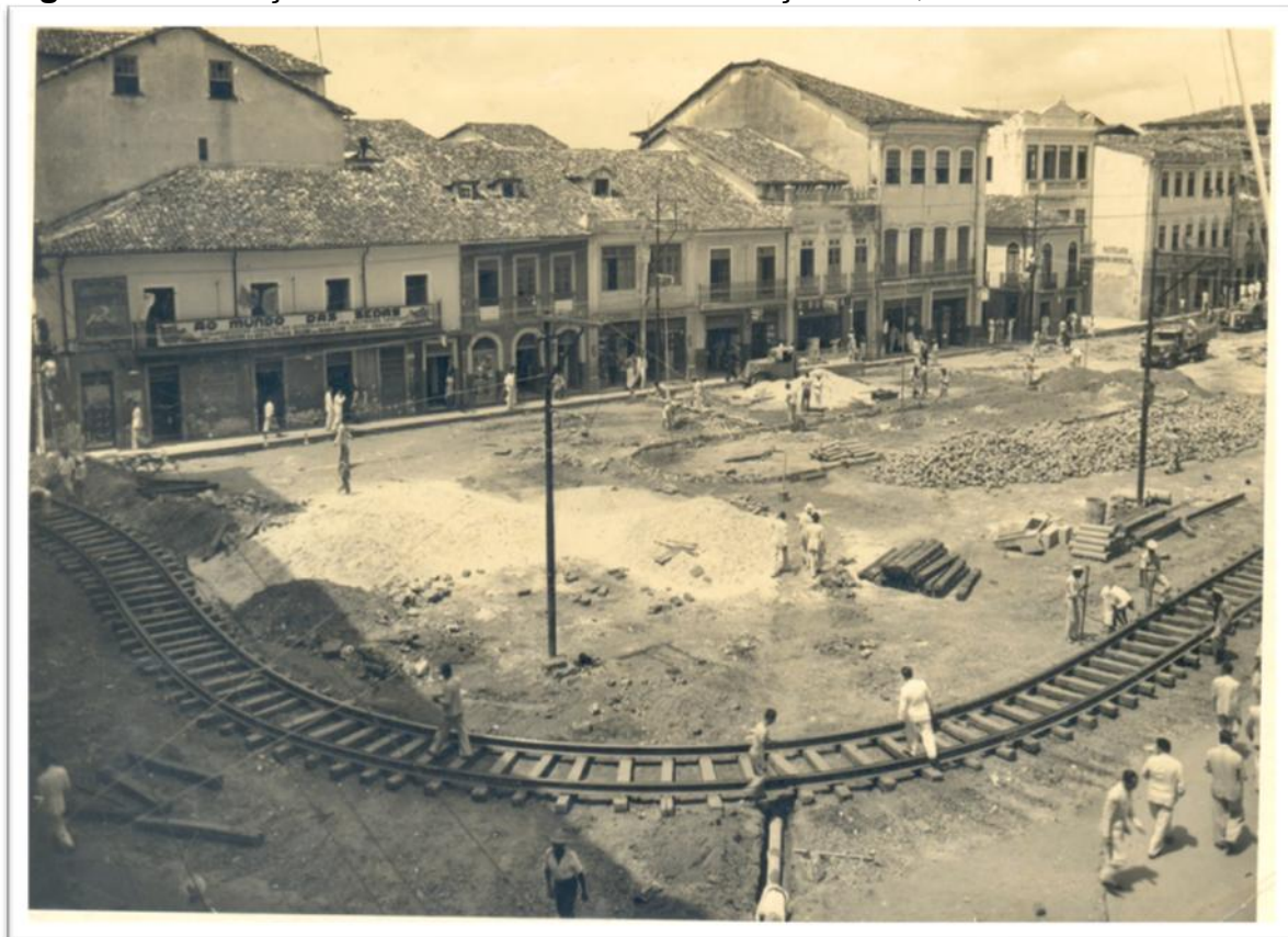
Figura 9: Instalação das linhas de bondes na Praça da Sé, década de 1930.
