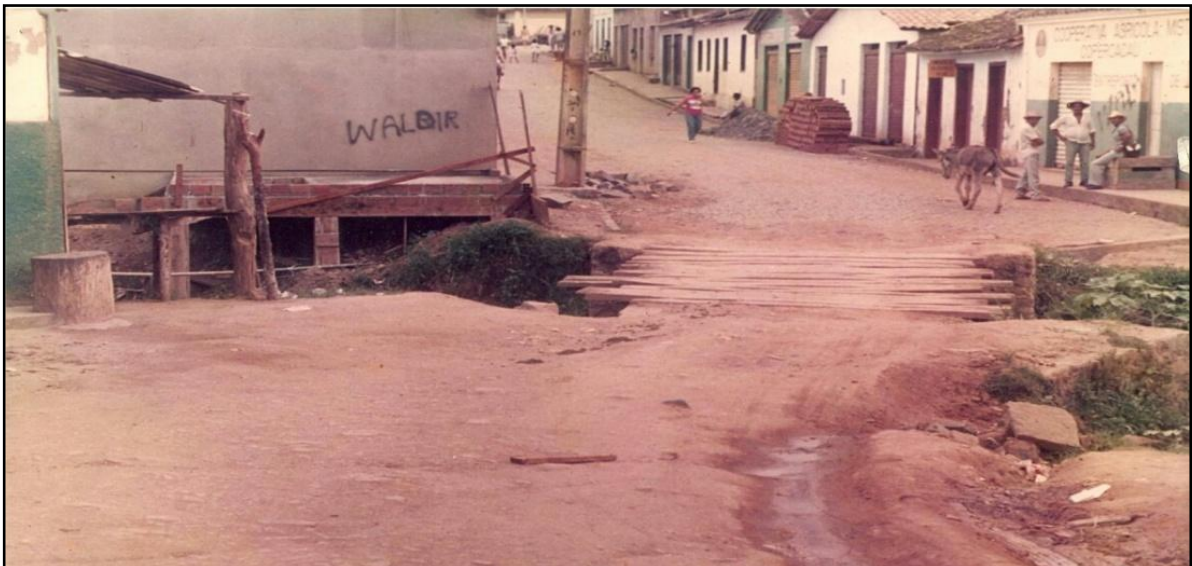
Figura 07 - Ponte que interligava os povoados de Apurema e Filanésia
