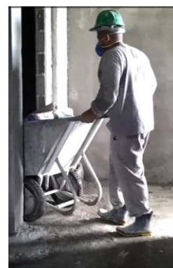
Figura 58: transporte dos sacos em padiola pelo andar (Fonte: O autor)
