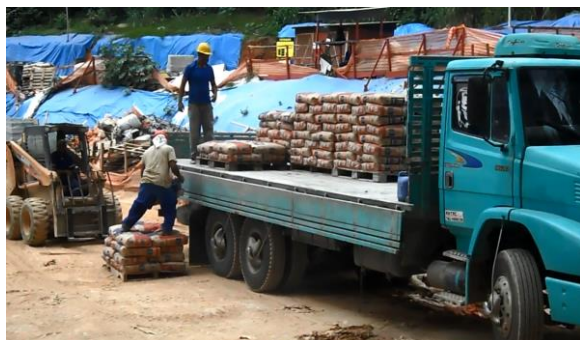
Figura 19: Descarregamento manual do caminhão (Fonte: O autor)
