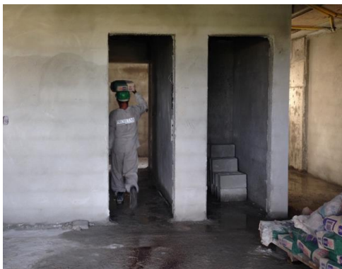
Figura 53: Transporte manual dos sacos (Fonte: O autor)
