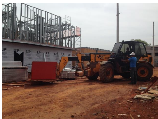
Figura 96: Transporte vertical pelo montador (Fonte: O autor)
