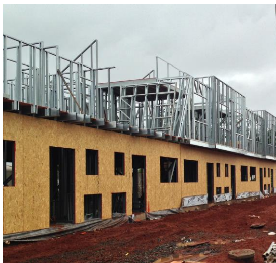
Figura 101: Instalação dos frames do primeiro andar sem a instalação da membrana hidrófuga no térreo (Fonte: O autor)
