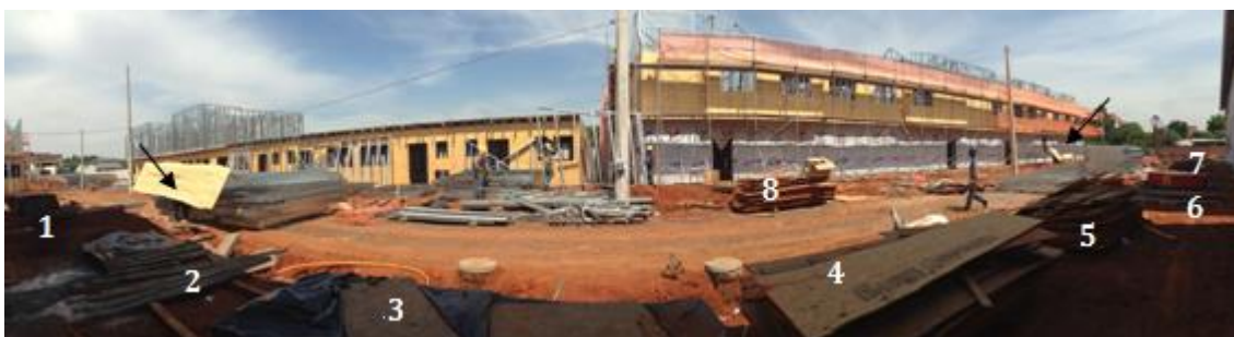
Figura 98: Oito estoques de OSB no canteiro perto do radier no qual será instalado o OSB (Fonte: O autor)
