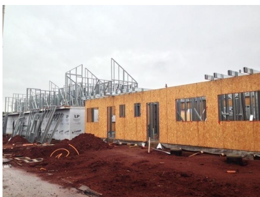
Figura 86: OSB do térreo e OSB com a membrana hidrófuga (Fonte: O autor)
