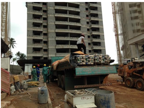
Figura 44: Conferência da argamassa ensacada transportada em pallets (Fonte: O autor)
