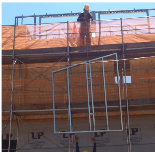
Figura 103: Transporte vertical de um frame ajudado por cordas realizado por dois montadores (Fonte: O autor)
