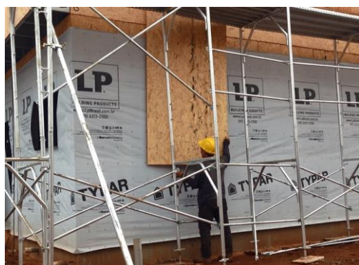
Figura 96: Transporte vertical pelo montador (Fonte: O autor)
