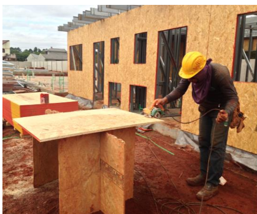
Figura 99: Realização dos cortes do OSB no exterior da casa (Fonte: O autor)
