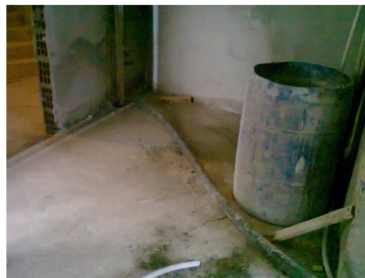
Figura 31: Subida da mangueira através do furo da laje (Fonte: O autor)
