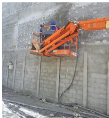
Figura 35: Mangueira utilizada para o transporte da argamassa pronta (Fonte: O autor)
