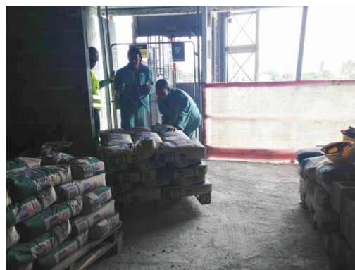
Figura 51: Transporte via paleteira desde o elevador até o estoque no andar (Fonte: O autor)
