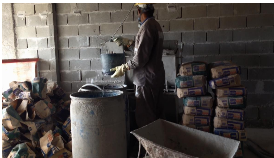
Figura 74: Pedreiro encarregado da produção de argamassa transportando balde com água (Fonte: O autor)
