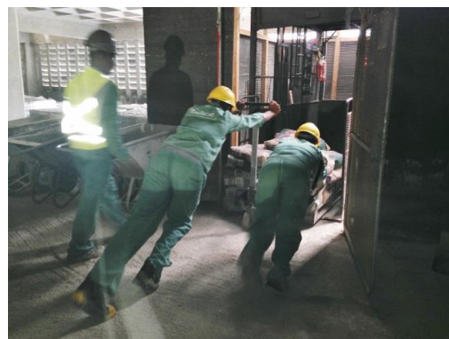
Figura 49: Transporte via paleteira até dentro do elevador (Fonte: O autor)
