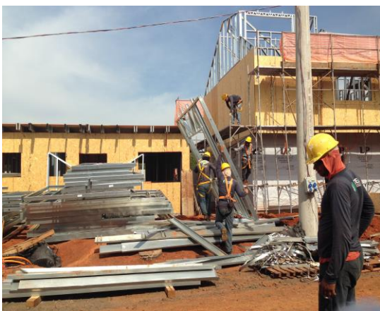
Figura 108: Frames estocados nas vias de acesso (Fonte: O autor)
