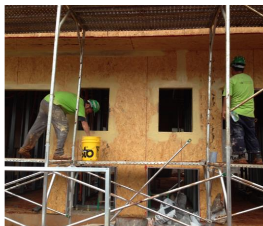
Figura 87: Realização da fachada (Fonte: O autor)
