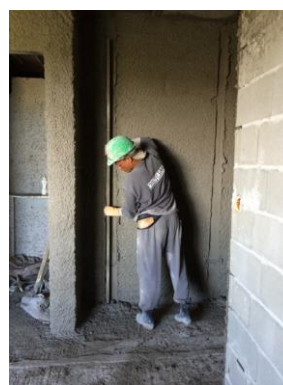
Figura 70: Sarrafamento da argamassa projetada (Fonte: O autor)
