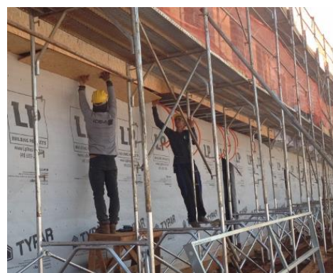
Figura 97: Instalação do OSB no destino final (Fonte: O autor)
