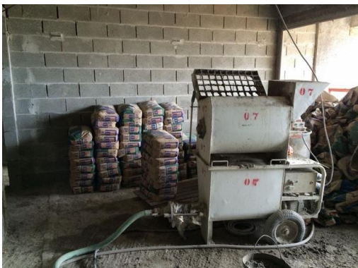
Figura 59: Estoque dos sacos em pilas junto a argamassadeira (Fonte: O autor)
