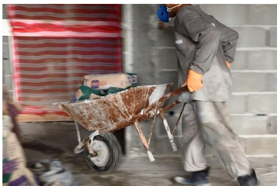
Figura 57: Transporte manual dos sacos até a padiola (Fonte: O autor)
