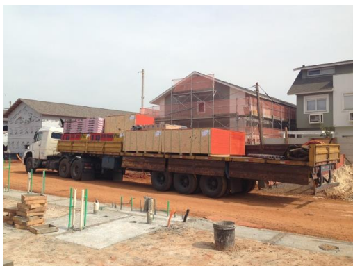
Figura 90: Entrada do caminhão ao canteiro (Fonte: O autor)
