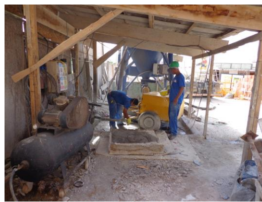
Figura 28: Mistura da argamassa na boca do silo (Fonte: O autor)
