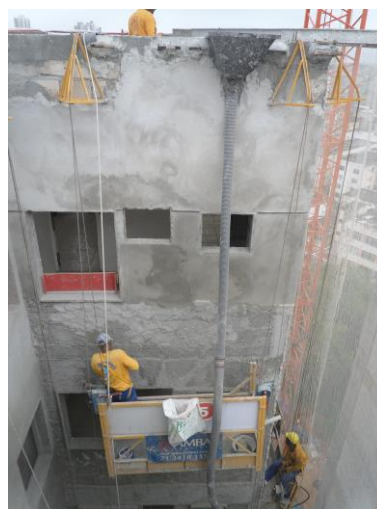
Figura 26: Transporte vertical da argamassa pronto por meio do funil (Fonte: O autor)
