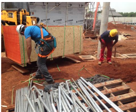
Figura 120: Motorista improvisa base para o estoque durante a atividade de transporte (Fonte: O autor)
