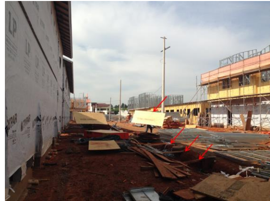
Figura 116: Trabalhador transportando placa de OSB sobre rampas improvisadas sobre as escavações (Fonte: O autor)
