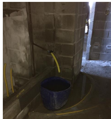
Figura 65: Estoque de água em toneis junto a argamassadeira (Fonte: O autor)
