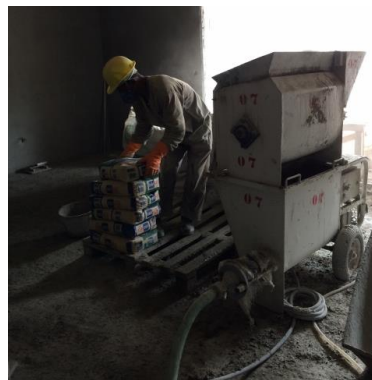
Figura 60: Transporte manual da pila até argamassadeira (Fonte: O autor)
