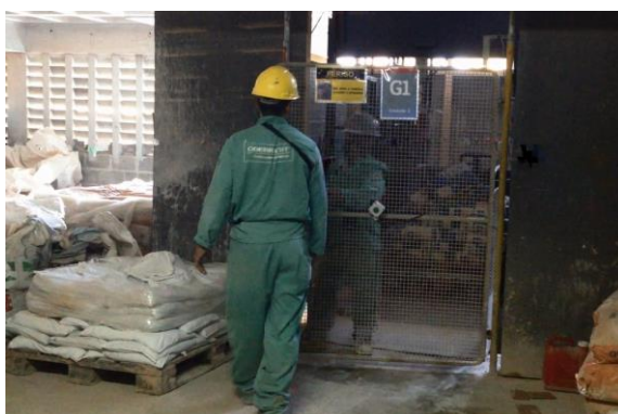
Figura 50: Transporte vertical do pallet no elevador cremalheira (Fonte: O autor)
