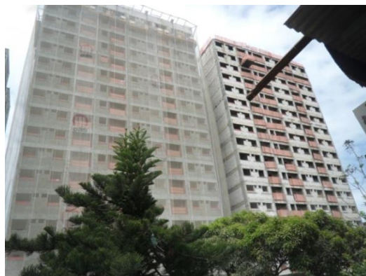
Figura 10: Fachada estudada da Obra A (Fonte: O autor)
