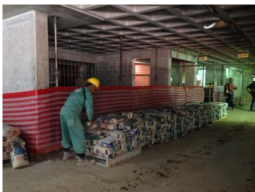
Figura 48: Estoque perto do elevador cremalheira até liberação da subida (Fonte: O autor)
