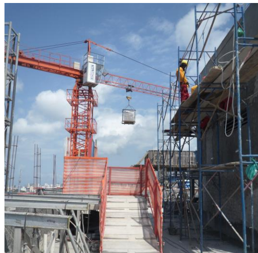
Figura 22: Transporte vertical dos sacos por meio da grua (Fonte: O autor)
