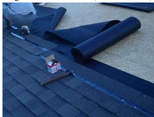
Figura 85: Telhamento (Fonte: O autor)
