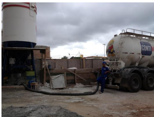
Figura 29: Enchimento do silo via mangueira desde o caminhão (Fonte: O autor)
