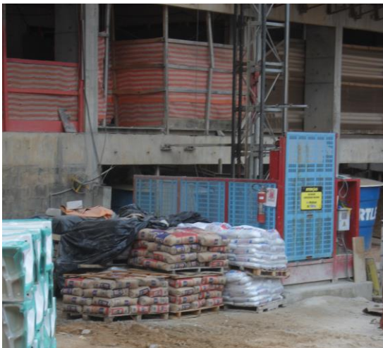
Figura 21: Armazenagem dos sacos perto do elevador cremalheira no térreo (Fonte: O autor)
