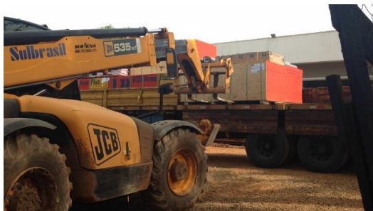
Figura 92: Descarregamento do caminhão pelo manipulador telescópico (Fonte: O autor)
