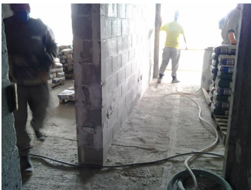
Figura 64: Mangueira para transporte de água pelo andar (Fonte: O autor)
