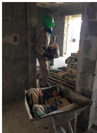
Figura 78: O pallet de sacos se encontra muito próximo a porta dificultando a entrada ao ambiente (Fonte: O autor)
