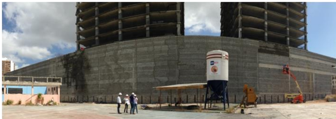
Figura 12: Fachada acompanhada na obra C (Fonte: O autor)
