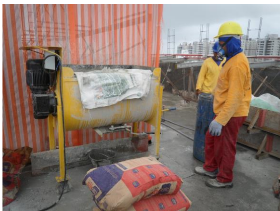
Figura 17: Argamassadeira, depósito de água junto à argamassadeiras e sacos de argamassa na cobertura (Fonte: O autor)
