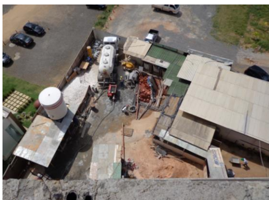
Figura 27: Entrada ao canteiro (Fonte: O autor)
