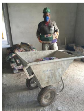
Figura 57: Transporte manual dos sacos até a padiola (Fonte: O autor)
