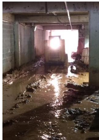
Figura 80: O acesso com lama faz com que a carregadeira demore mais tempo no transporte do pallet com sacos (Fonte: O autor)
