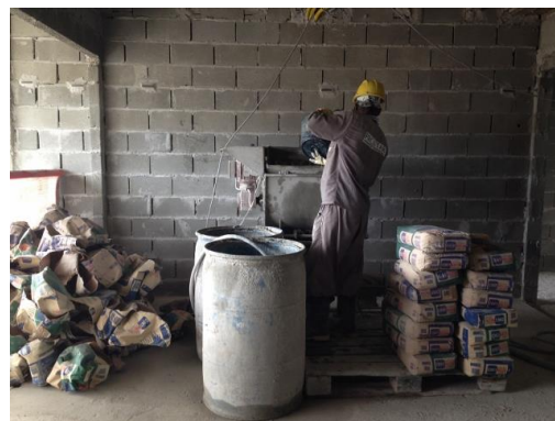
Figura 65: Estoque de água em toneis junto a argamassadeira (Fonte: O autor)
