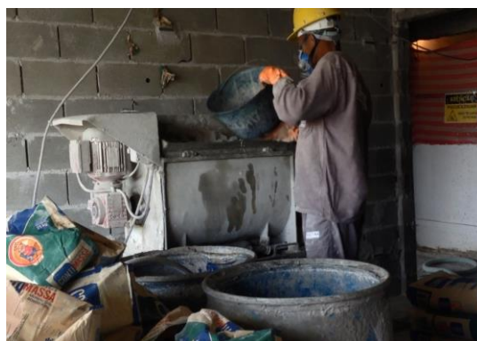
Figura 66: Transporte de água em balde desde os toneis até argamassadeira até a colocação da quantidade prevista (Fonte: O autor)
