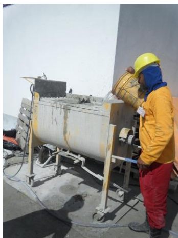
Figura 23: Transporte da água desde o depósito até argamassadeira por meio de balde (Fonte: O autor)
