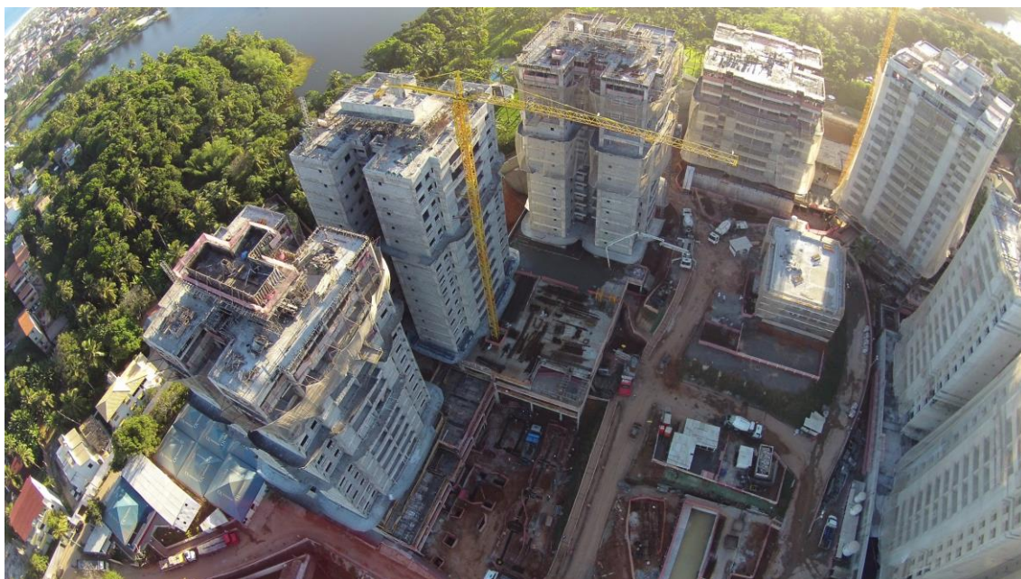
Figura 13: Vista do Canteiro da Obra D (Fonte: O autor)
