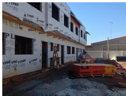
Figura 97: Instalação do OSB no destino final (Fonte: O autor)
