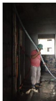
Figura 70: Sarrafamento da argamassa projetada (Fonte: O autor)
