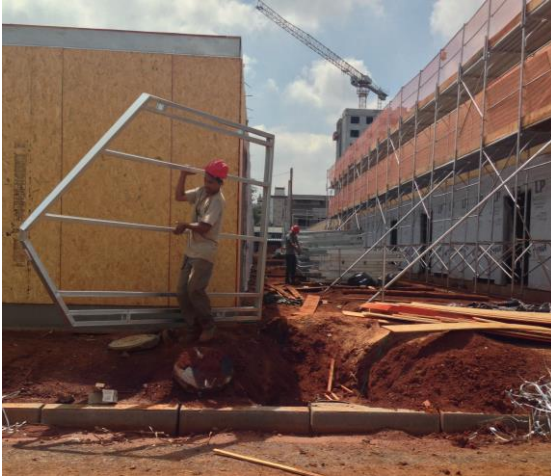
Figura 110: Colaborador transportando frame junto a um buraco no terreno (Fonte: O autor)
