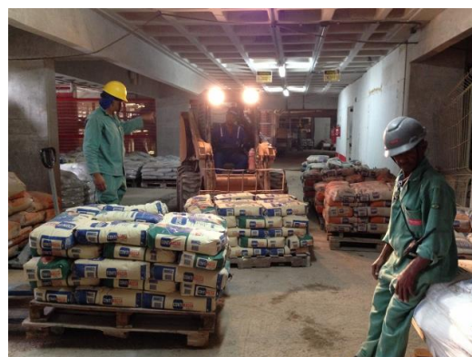
Figura 49: Transporte via paleteira até dentro do elevador (Fonte: O autor)
