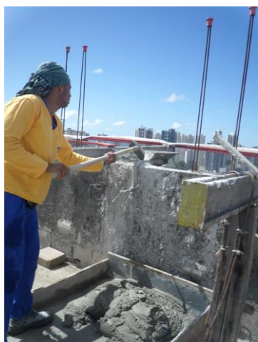
Figura 25: Transporte da argamassa pronta desde o caixote até o funil (Fonte: O autor)
