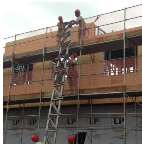
Figura 104: Transporte vertical de um frame realizado de forma manual por seis montadores (Fonte: O autor)
