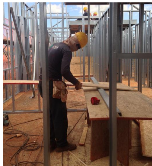
Figura 100: Realização dos cortes do OSB no interior da casa (Fonte: O autor)
