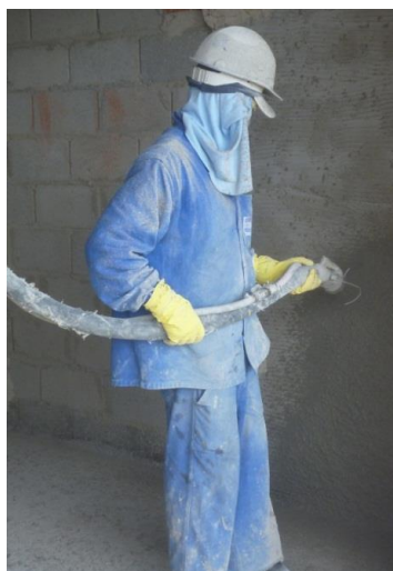
Figura 32: Projeção mecânica (Fonte: O autor)
