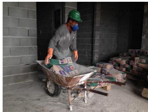
Figura 56: Transporte manual dos sacos desde o carrinho de mão até o estoque perto da argamassadeira (Fonte: O autor)
