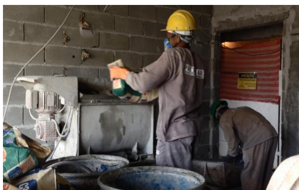
Figura 61: colocação da quantidade prevista na argamassadeira (Fonte: O autor)
