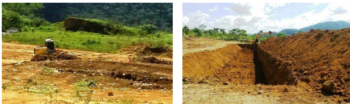
Figura 37 – Obras realizadas na melhoria emergencial no aterro sanitário do município de Ubaíra – 2014
