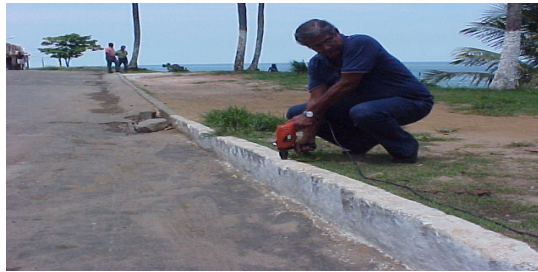
Figura 55- Meio fio geo sendo cravado pino
