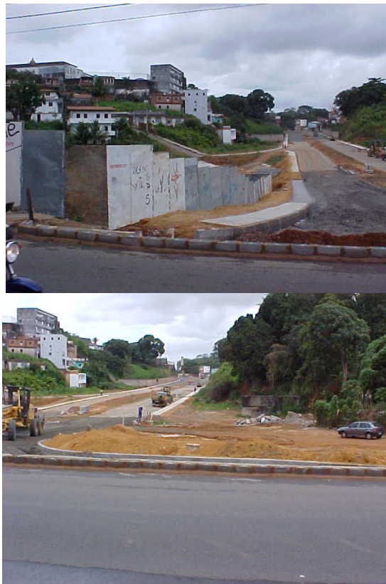
Figura 36 - Sistema viário, trecho da Estrada da Rainha ao Largo do Queimadinho (2005).
