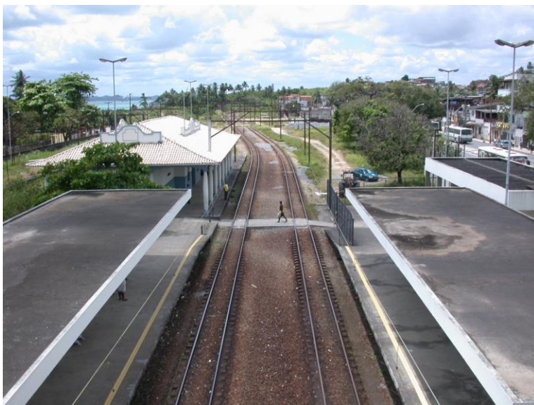
Figura 10 - Vista da via férrea na Estação de Periperi, vendo-se ao lado ônibus trafegando na Avenida Suburbana Fonte: CBTU
