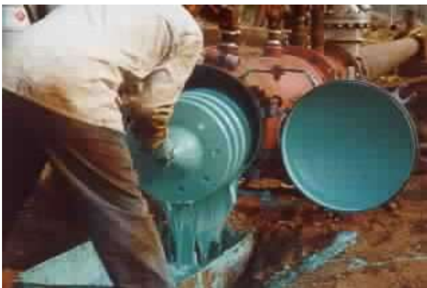
Figura 1.3 - Etapa de aplicação do revestimento no duto.
