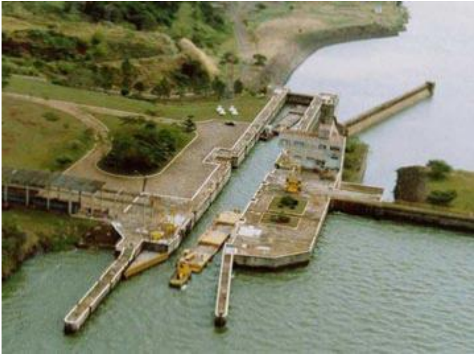
Figura 1.1: Eclusa em operação na Hidrovia Tietê-Paraná. Fonte: Wikipedia (2013) .
