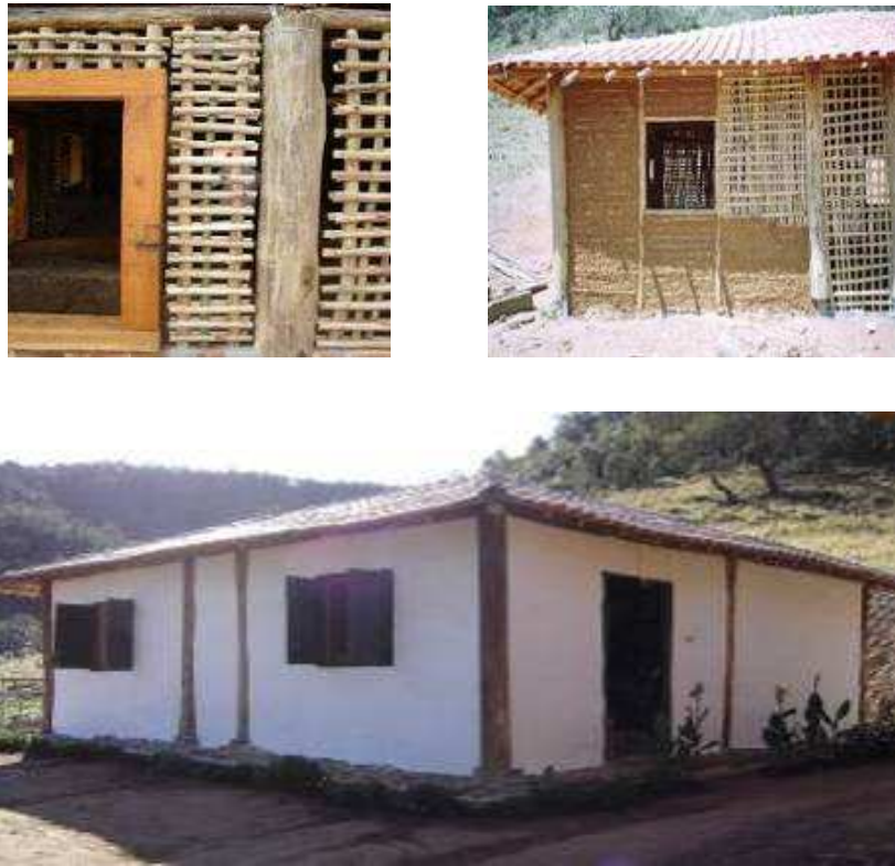
Figura 38 Pannel bambu a pique-estrutura em bambu e barro Fonte: Giannela (2007)
