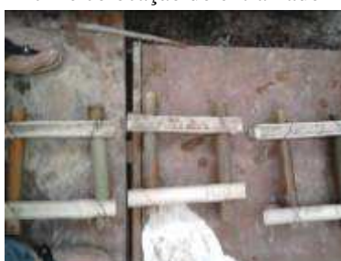
D CP 09 A, B e C – Entramado de Bambu com broca
