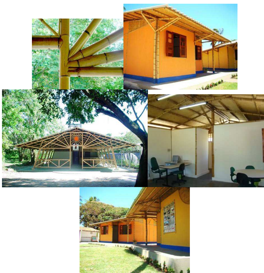
Figura 8 Casas de bambu rebocadas com cal e areia. Fonte: INCOMUN (2004)
