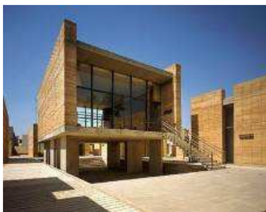
Figura 10 Arquitetura Contemporânea em terra - taipa de pilão Fonte: Rocha (2009)
