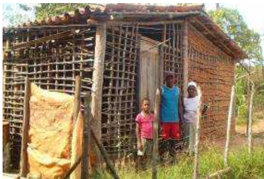
Figura 27 Taipa no bairro do Alegre em São Sebastião do Passé, Bahia, Brasil Fonte: Araújo (2007)
