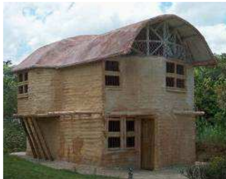
Figura 22 Casa de barro e bambu em zona rural na Colômbia. Fonte: Stamm (2007)
