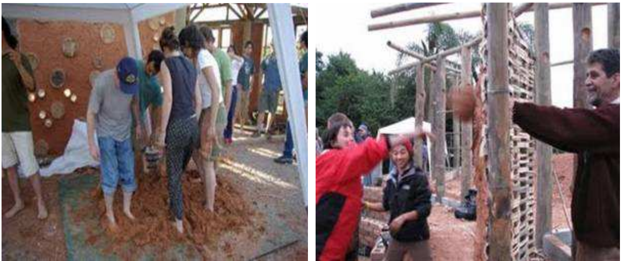
Figura 26 Pisando o barro e barreando os painéis Fonte: Nogueira (2009)
