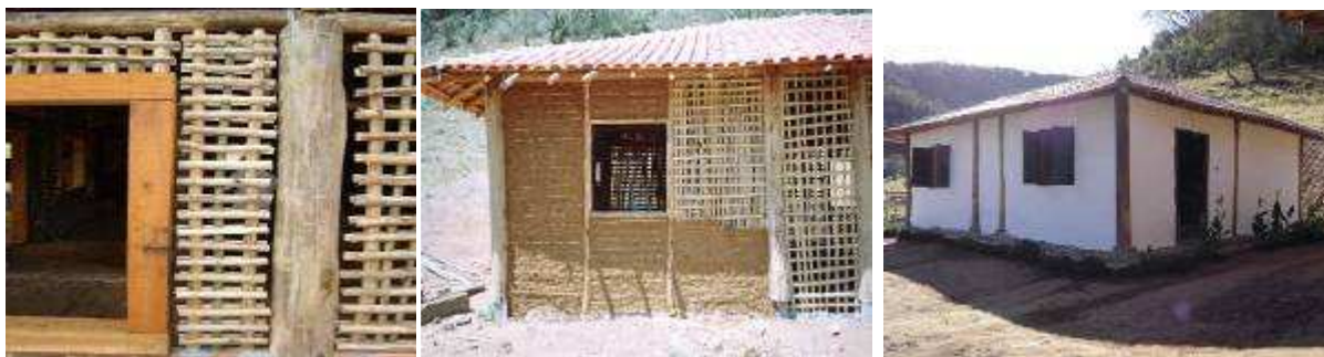
Figura 69 Vedação Vertical Bambu a Pique-bambu e barro
