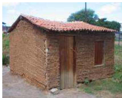
Figura 15 Casa de taipa sem reboco - Brasil Fonte: Patrick (2005)
