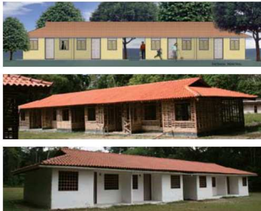
Figura 28 Casa com estrutura em bambu – Vila ecológica - Comunidade científica da Reserva Florestal Adolpho Ducke - Manaus Fonte: SÁ RIBEIRO, M.G. e SÁ RIBEIRO R.A. (2008)
