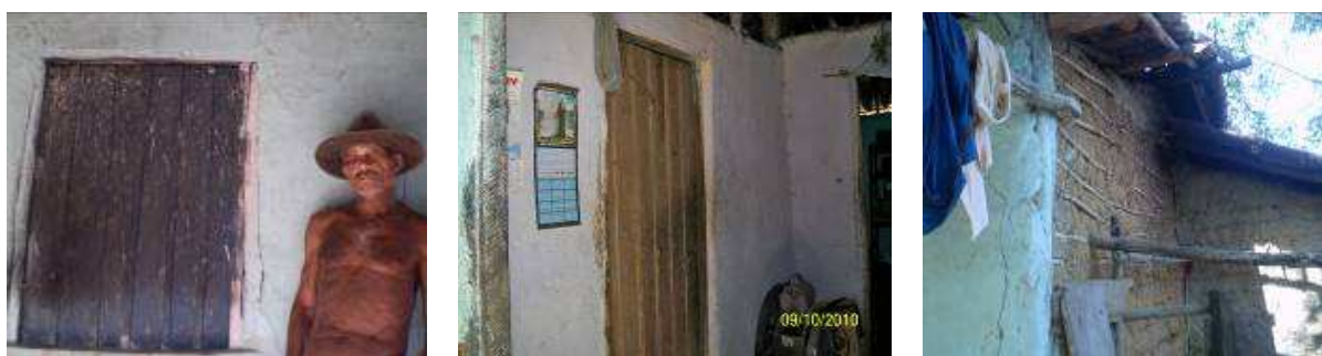
Figura 83 Casa de taipa S.F. do Conde construída por Cassiano de Brito
