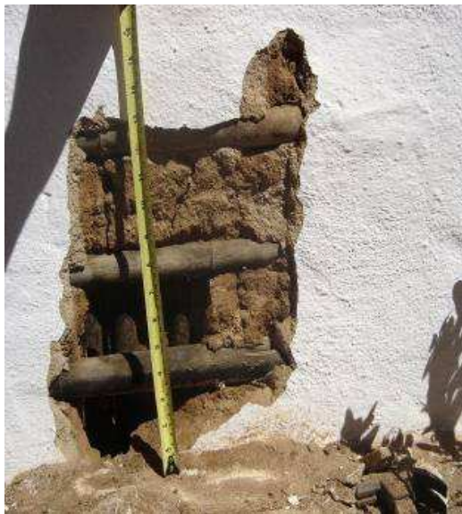
Figura 39 Sondagem em parede de bambu e barro para verificar a degradação do entramado de bambu e afastamento do painel do chão sugerido pelo construtor.
