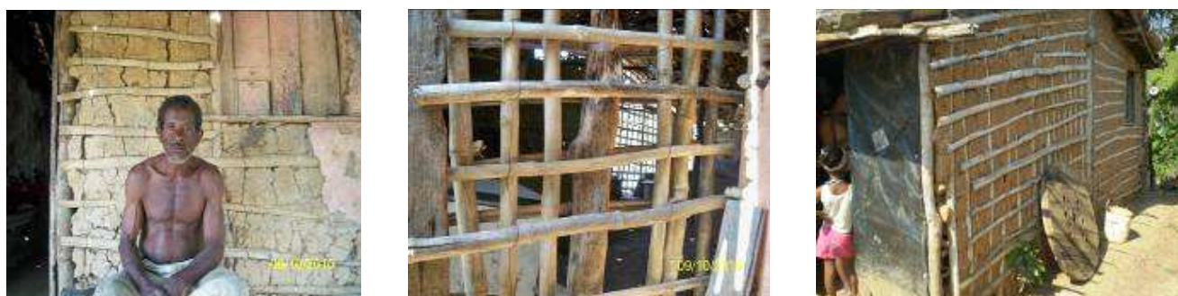
Figura 85 Casa de taipa S.F. do Conde construída por Antonio dos Santos
