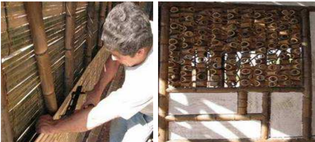
Figura 25 Paredes em bambu sendo executadas no CES Fonte: Nogueira (2009)
