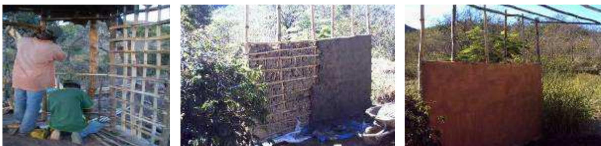
Figura 70 Vedação Protótipo – estrutura em bambu e enchimento com barro.
