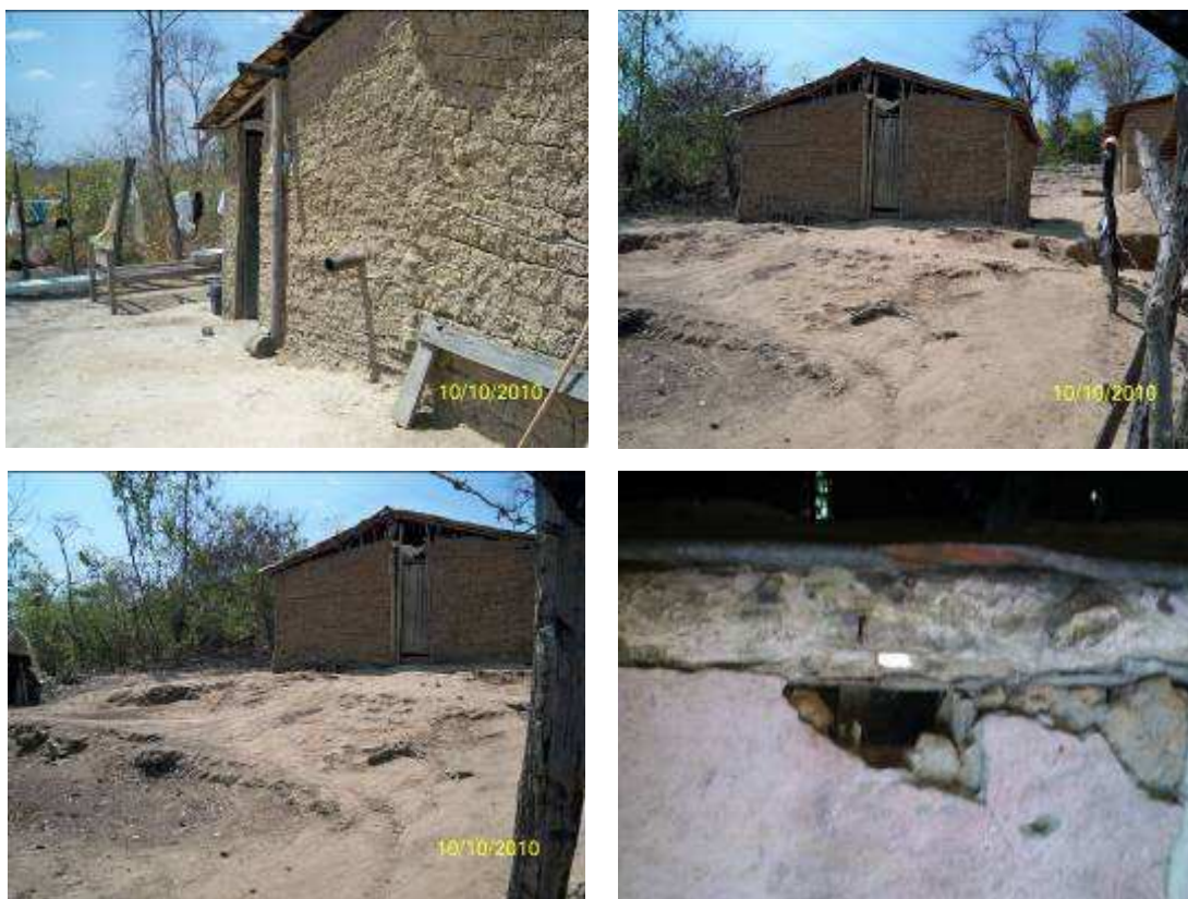
Figura 81 Casa construída em taipa e madeira em Andaraí - Arlindo Silva
