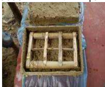
B Preenchimento de terra com 4cm e colocação do entramado
