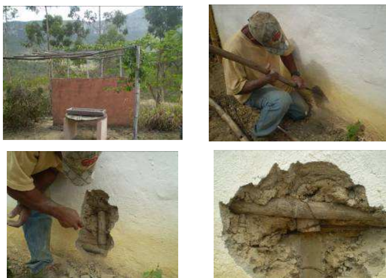
Figura 66 Retirada de montantes para análise e ensaio de resistência à compressão.
