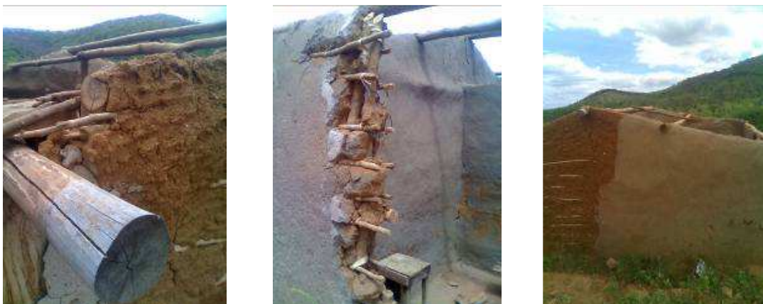
Figura 73 Casa de taipa em construção por Gilberto Anchieta no município de Boa Vista do Tupim
