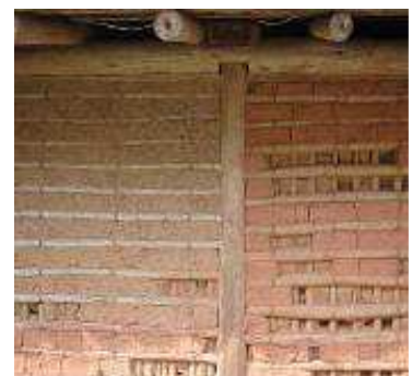
Figura 16 Taipa sem reboco no interior do Nordeste - Brasil Fonte: Gianella (2007)
