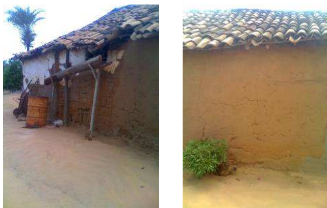
Figura 74 Casa de Taipa construída por Ireno no município de Boa Vista do Tupim
