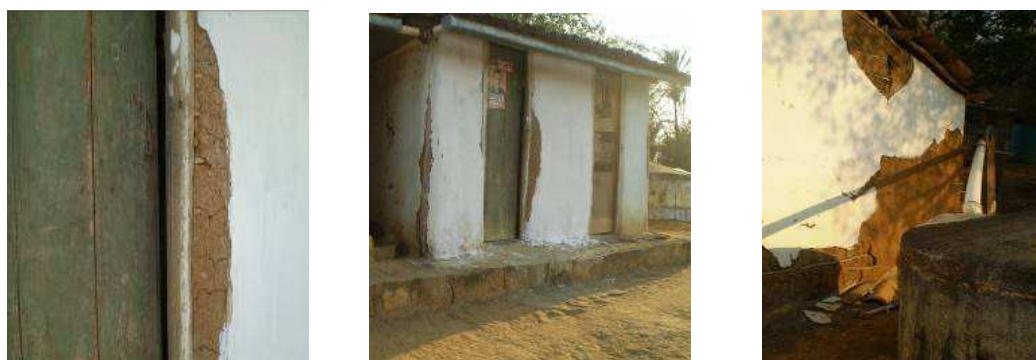
Figura 75 Casa construída por Adelino em taipa e madeira no município de Boa Vista do Tupim
