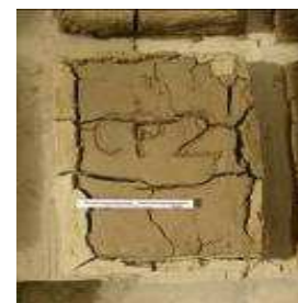
C Rachaduras no CP 02 marcadas com escalímetro
