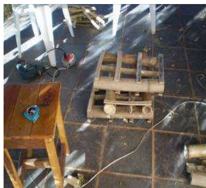
Figura 42 Entramado em processo de execução
