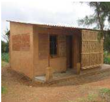
Figura 14 Casa de taipa rebocada em Angola Fonte: Soares (2009)
