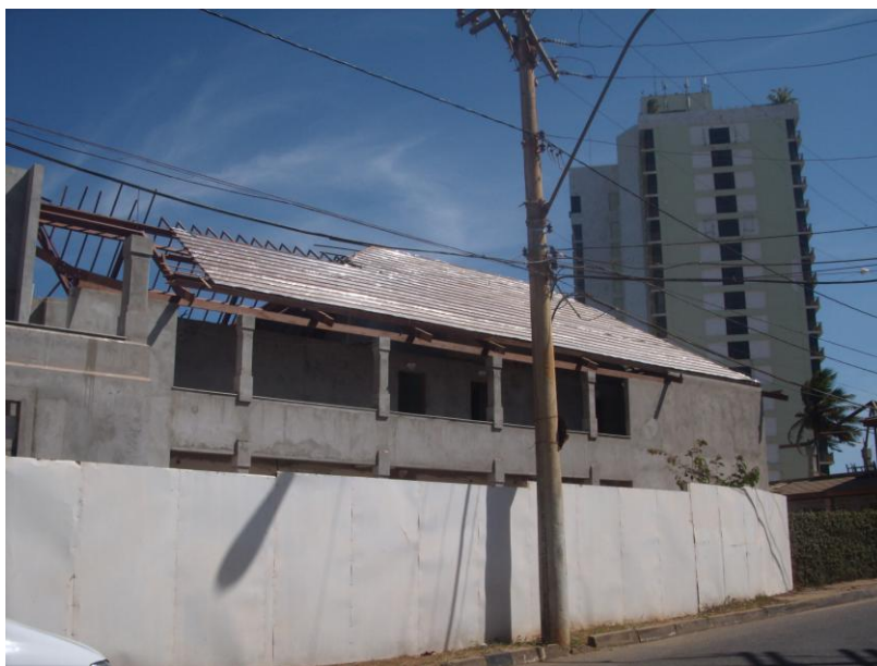
Figura 27 - Telhado sendo preparado com manta de alumínio para receber telha Taubilha
