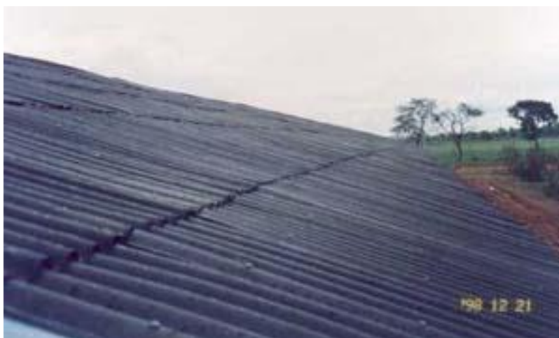
Figura 10 - Telha Ecológica Produzida com Resíduo de Papel. Fonte: http://www.tecolit.com.br/fotos.htm
