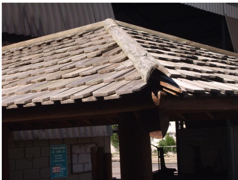
Figura 25 - Telha Taubilha na cobertura de quiosque
