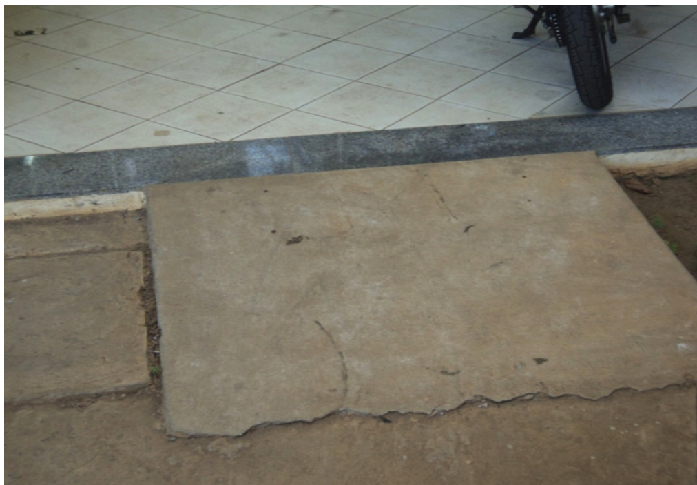
Figura 11 - Rampa de acesso do estacionamento dos alunos
