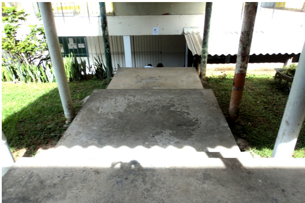
Figura 5 - Escada de acesso à Coordenação e salas de Artes
