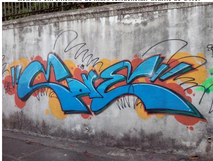
Figura 53 - Região do Santo Antônio. Ladeira Ramos de Queiroz. Letrado em extensão de muro residencial. Grafite de Core.
