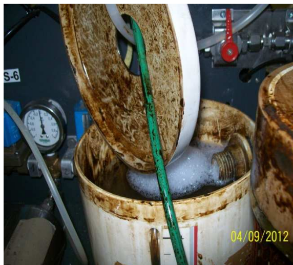
Figura 27 – Aspectos do sistema de MF antes do início do processo de limpeza química - interior do TQ-2
