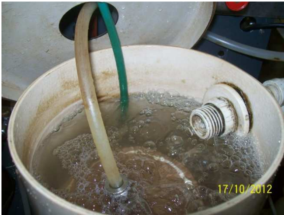
Figura 22 – Aspectos das membranas de MF - vista do TQ-2 com o módulo das membranas submerso em operação
