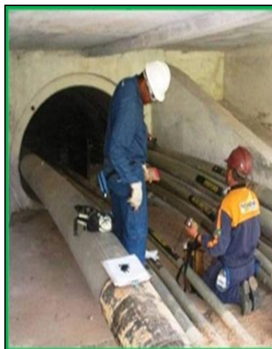
Figura 17: Inspeção de trechos aéreos Fonte: DUTOVIA: apresentação de riscos.ppt (2012)
