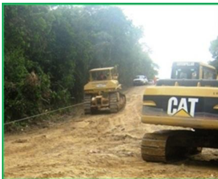
Figura 15: Inspeção e manutenção da faixa.
