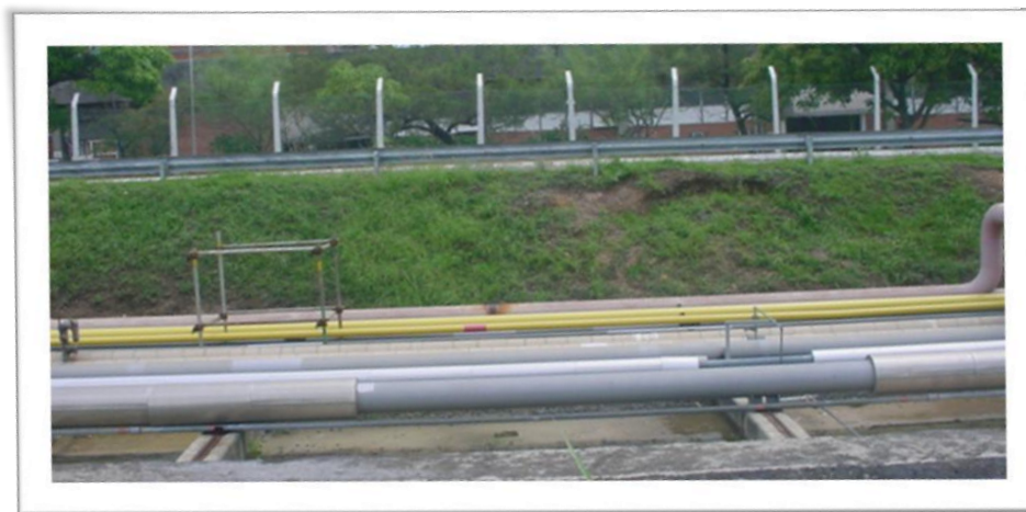
Figura 12: Via de Dutos
