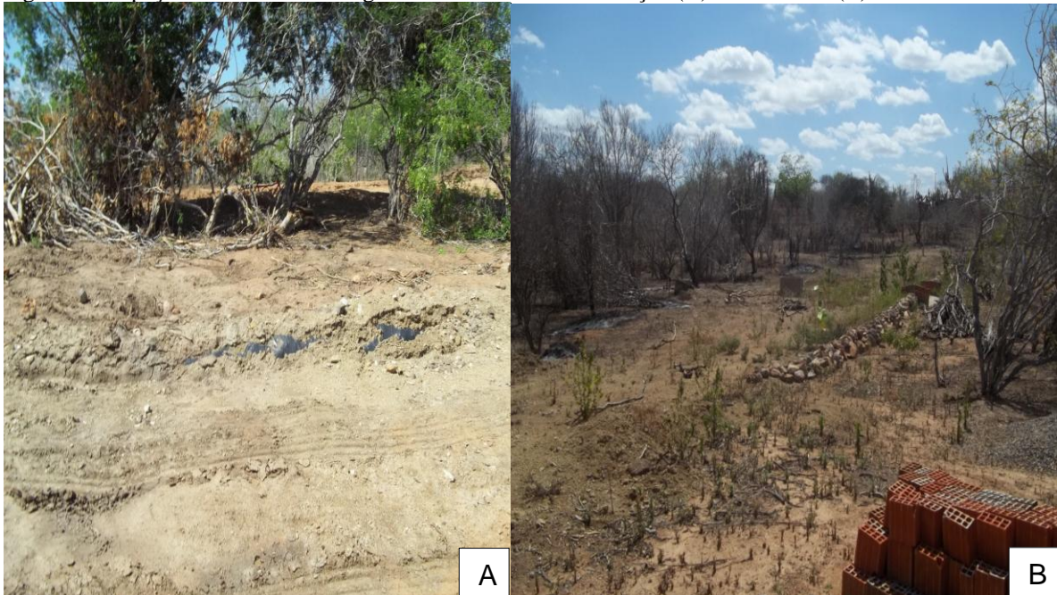
Figura 8 – Espaço Produtivo da Barragem subterrânea: em construção (A) e construída (B)
