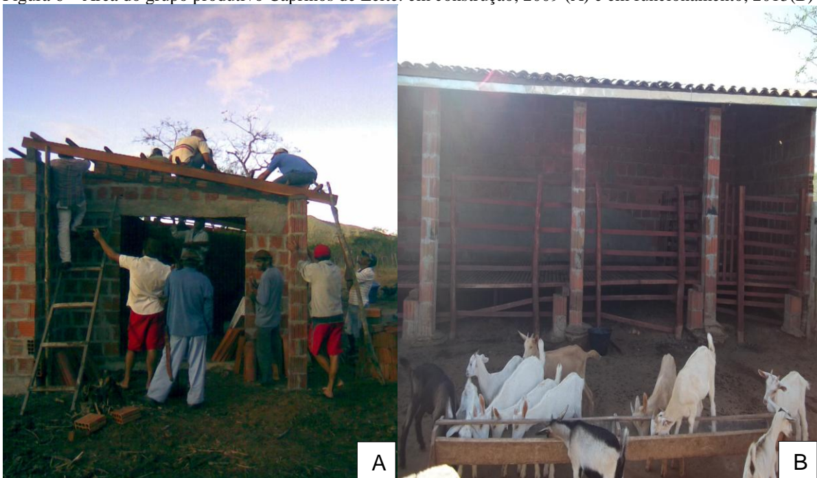
Figura 6 – Área do grupo produtivo Caprinos de Leite: em construção, 2009 (A) e em funcionamento, 2013(B)
