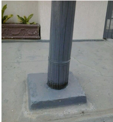
Figura 03 – Concreto na base do poste de madeira
