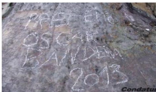
Figura 18 – Dilapidação. Fonte: < www.portalcdp.com.br >.
