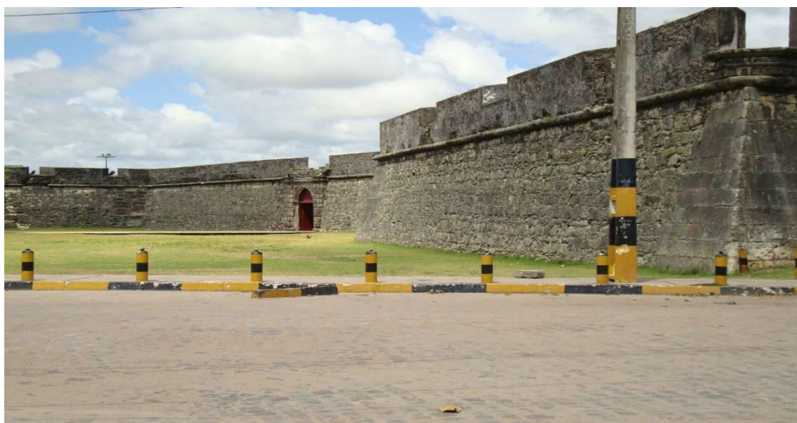
Figura 38 – Fortaleza de Santa Catarina: reconstrução com alvenaria de pedras, século XVII.
