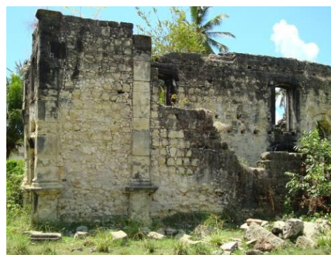
Figura 41 – Convento do Almagre: ruína da fachada oeste
