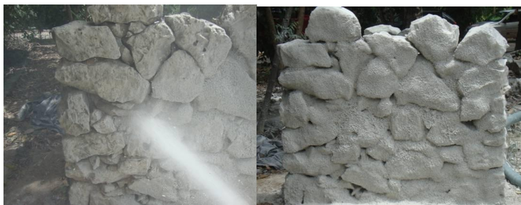
Figura 95 – Jateamento sobre a parede. Figura 96 – Parede jateada. Fonte: Paulo Germano Toscano Moura (2011).
