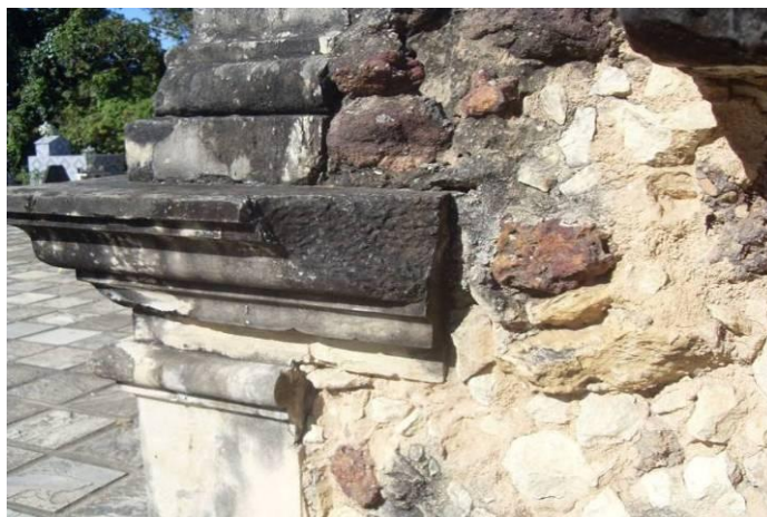
Figura 5 – Junção da alvenaria de pano único com pedras irregulares, com alvenaria trabalhada e cantaria. (Igreja da Guia-Lucena-PB). Fonte: Paulo Germano Toscano Moura (2009).
