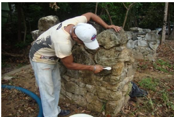
Figura 90 – Limpeza das pedras para aplicação da argamassa projetada. Fonte: Paulo Germano Toscano Moura (2011).
