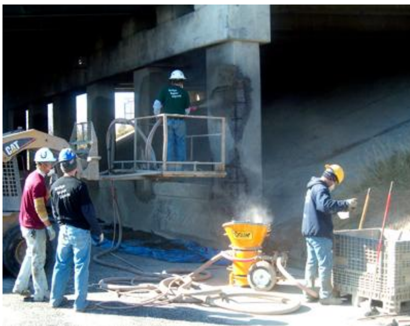
Figura 33 – Aplicação da tecnologia de argamassa projetada Via Seca na recuperação do concreto armado. Fonte: GUNITE – Supply & Equipment (2012).
