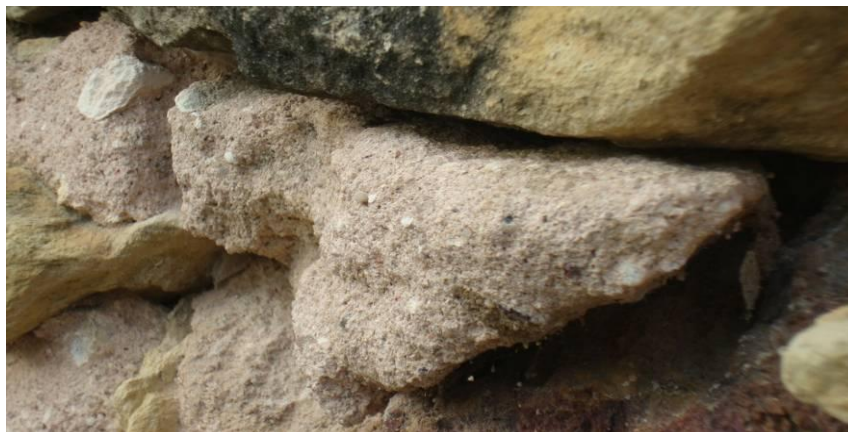
Figura 19 – Desestabilização de alvenarias. Base de parede da Fortaleza de Santa Catarina, Cabedelo-PB. Fonte: Paulo Germano Toscano Moura (2009).
