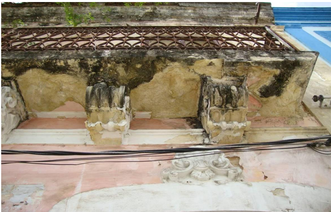
Figura 14 – Desagregação. Sobrado na Rua Duque de Caxias, João Pessoa-PB. Fonte: Paulo Germano Toscano Moura (2009).
