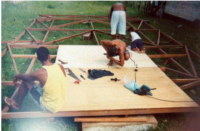
Figura 3 Construção da casa flutuante
