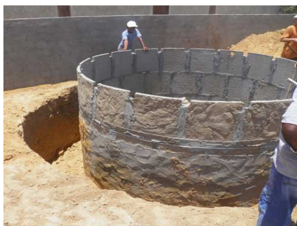
Figura 7: Estrutura com arame e reboco
