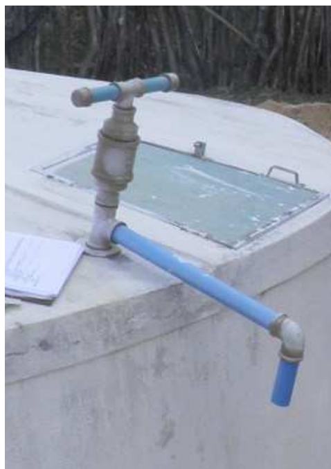
Figura 14: Bomba Manual de PVC
