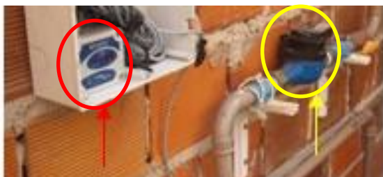
Figura 4 - Ilustração do sistema de monitoramento utilizado. Seta vermelha indica o data logger , seta amarela indica o hidrômetro
