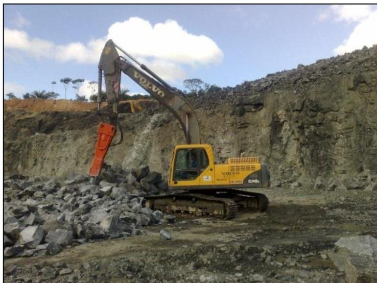
Figura 27 - Fragmentação de blocos de rocha com rompedor hidráulico.
